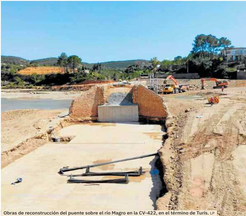
Obras de reconstrucción del puente sobre el río Magro en la CV-422, en el término de Turís. LP
