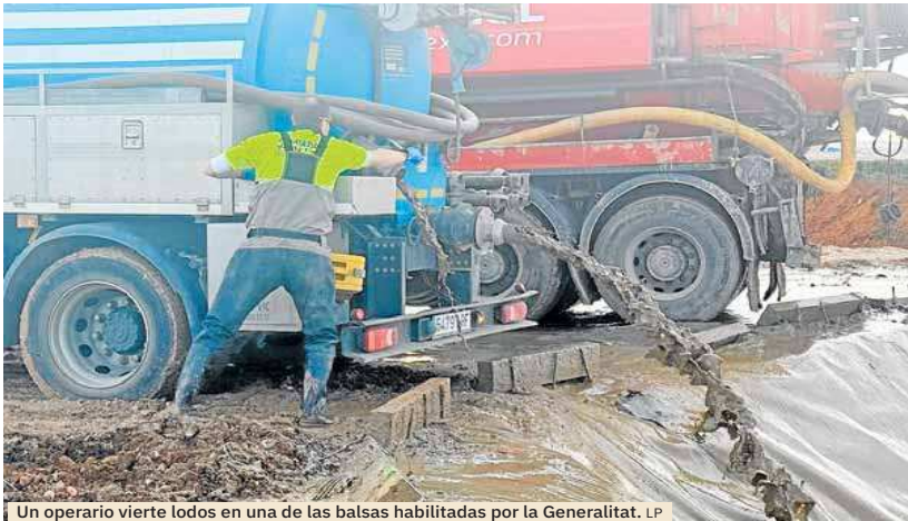
Un operario vierte lodos en una de las balsas habilitadas por la Generalitat. LP
