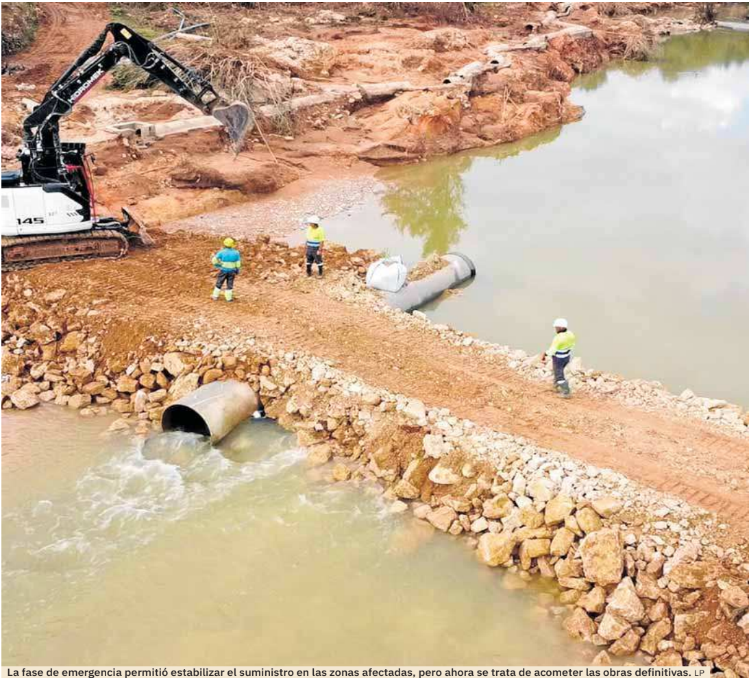
La fase de emergencia permitió estabilizar el suministro en las zonas afectadas, pero ahora se trata de acometer las obras definitivas. LP
