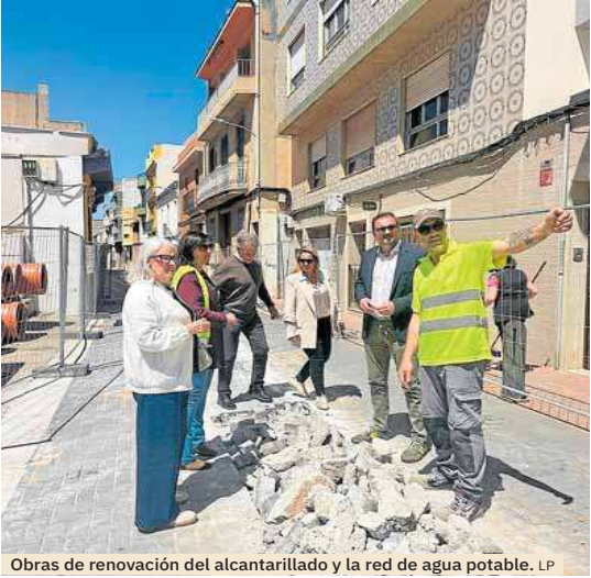
Obras de renovación del alcantarillado y la red de agua potable. LP
