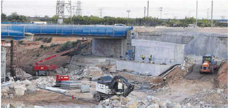
LECHO DEL POYO EN PICANYA Trabajos de reconstrucción, el pasado viernes.
