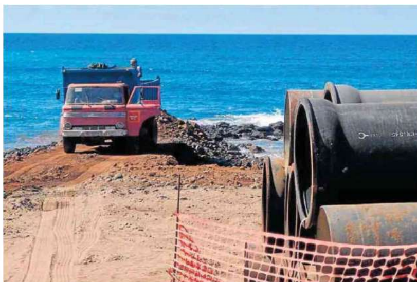
Trabajos de instalación del actual desagüe existente en la playa galdense de Bocabarranco. c7
